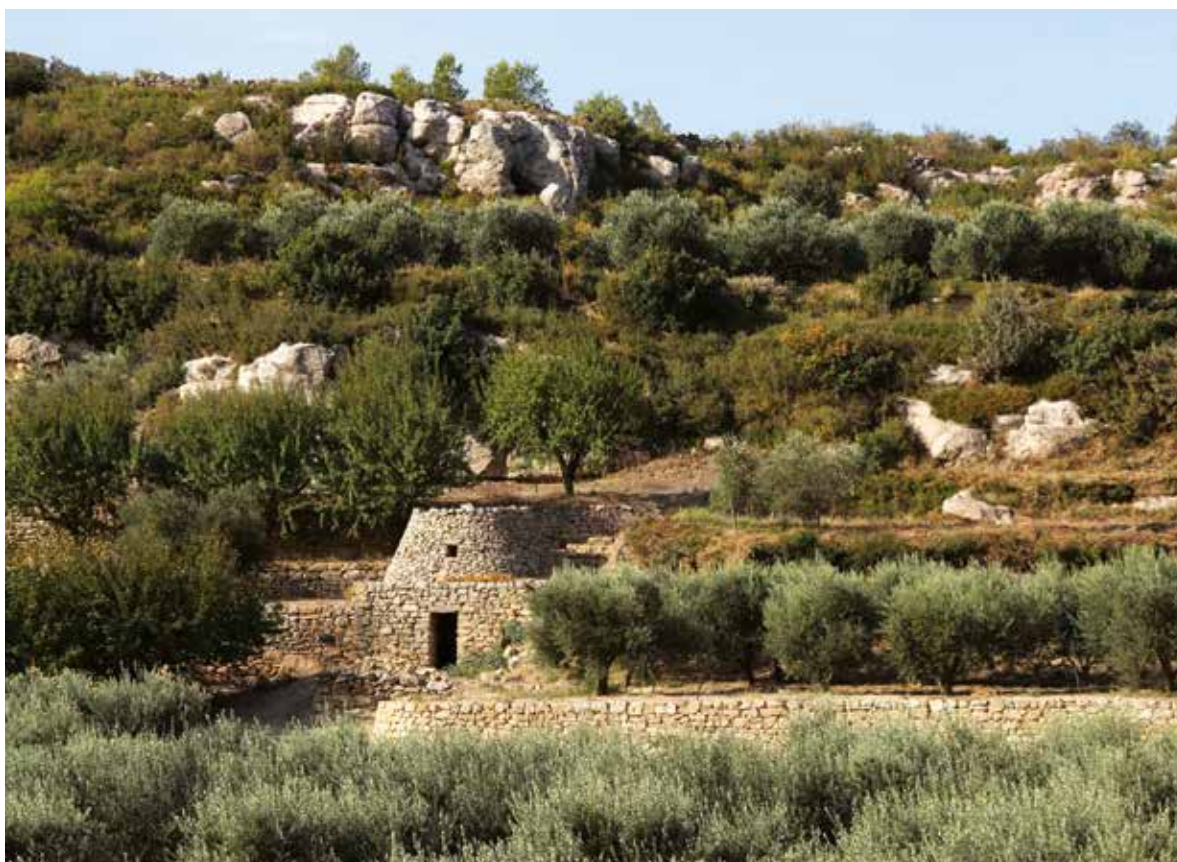
Les Bories du Tallagard à Salon-de-Provence ★ Des petits abris en pierre sèche où les bergers pouvaient s'y abriter de la pluie et du soleil, y entreposer quelques outils, voire dormir à proximité du troupeau.
